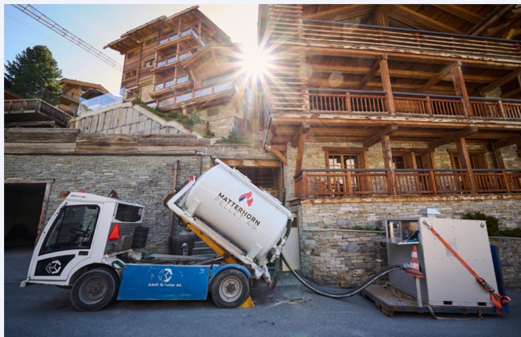
Anlieferung der Holzpellets, die aus den umliegenden Wäldern von Zermatt stammen.
